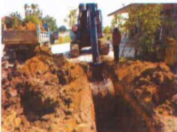
โครงการก่อสร้างวางระบายน้ำ คสล.รูปตัวยูพร้อมฝาปิด ถนนสายกลางบ้านท่าช้าง หมู่ที่ ๑๓ ช่วงหน้าบ้านนายยังถึงถนน ทางรถไฟ
