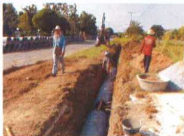
โครงการก่อสร้างวางระบายน้ำ คสล.รูปตัวยูพร้อมฝาปิด ถนนสายกลางบ้านท่าช้าง หมู่ที่ ๑๓ ช่วงหน้าบ้านนายยังถึงถนน ทางรถไฟ
