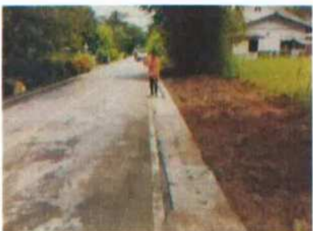
โครงการก่อสร้างวางระบายน้ำ คสล.รูปตัวยูพร้อมฝาปิด ถนนสายกลางบ้านท่าช้าง หมู่ที่ ๑๓ ช่วงหน้าบ้านนายยังถึงถนน ทางรถไฟ
